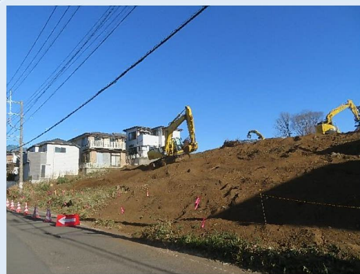
伐採工事をを行い、宅地造成を進めていきます。
