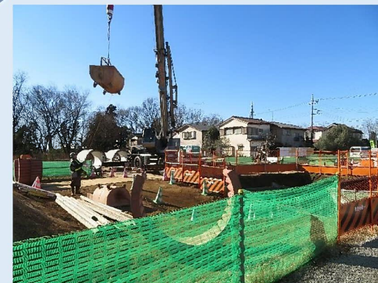
雨水推進工事を進めています。
