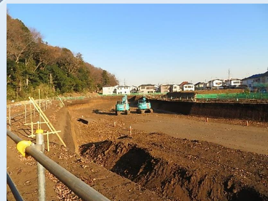
調整池工事が進んでいます。
